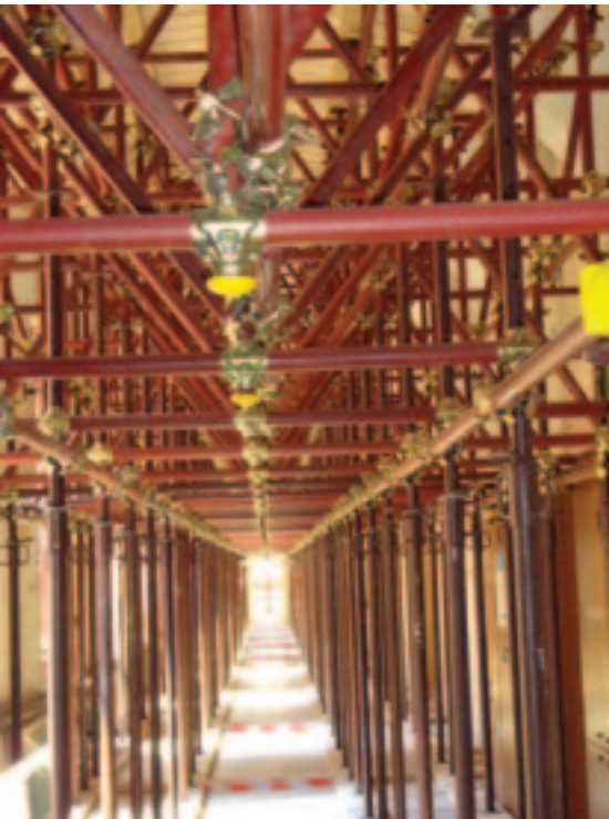
Esempio di puntellamento solaio
