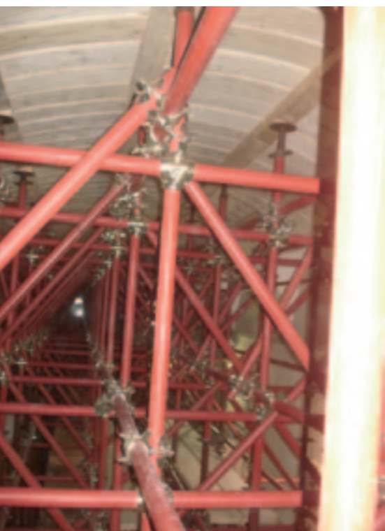
Puntellamento volta
