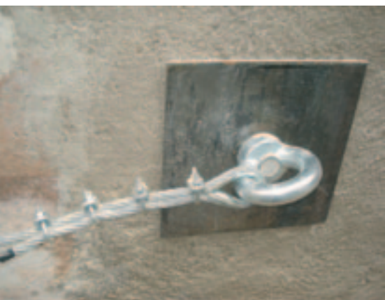
Applicazione tirante con piastra metallica
