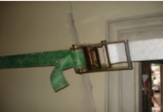
Particolare del sistema di chiusura della fascia
