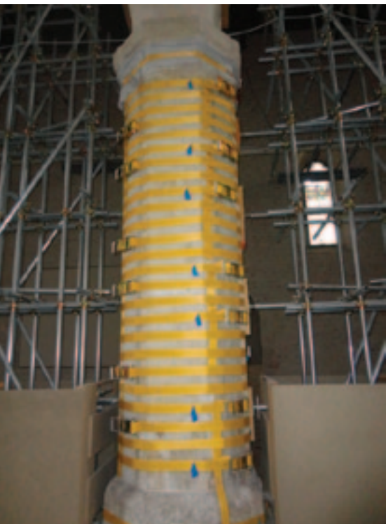
Cerchiatura di una colonna con fasce in poliestere
