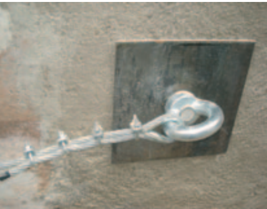
Applicazione tirante con piastra metallica
