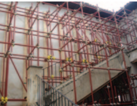
Puntellamento di parete pericolante
