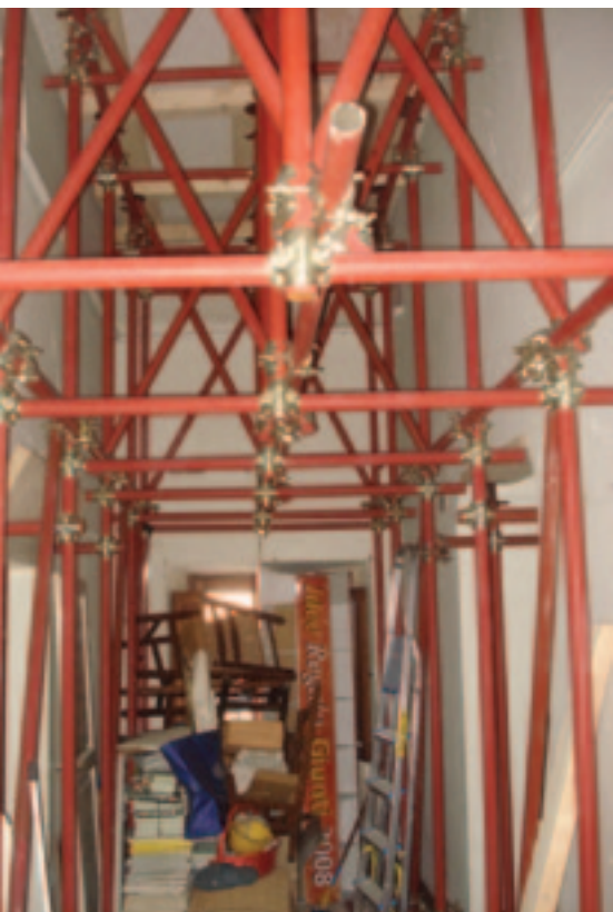
Esempio di puntellamento solaio
