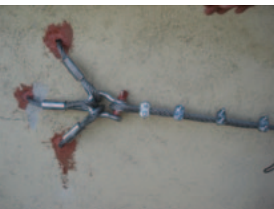
applicazione tirante con resine
