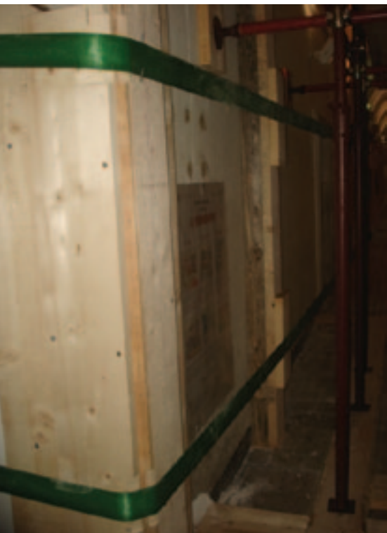
Particolare della posa negli angoli
