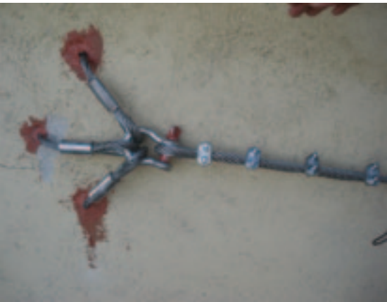
Applicazione tirante con resine
