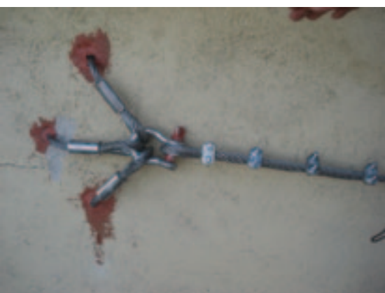
Applicazione tirante con resine
