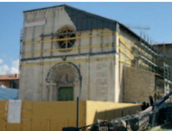
Particolare di fasciatura in poliestere
