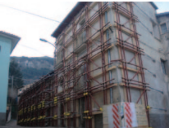
Esempio di cerchiatura con tubi e giunti e cavi in acciaio
